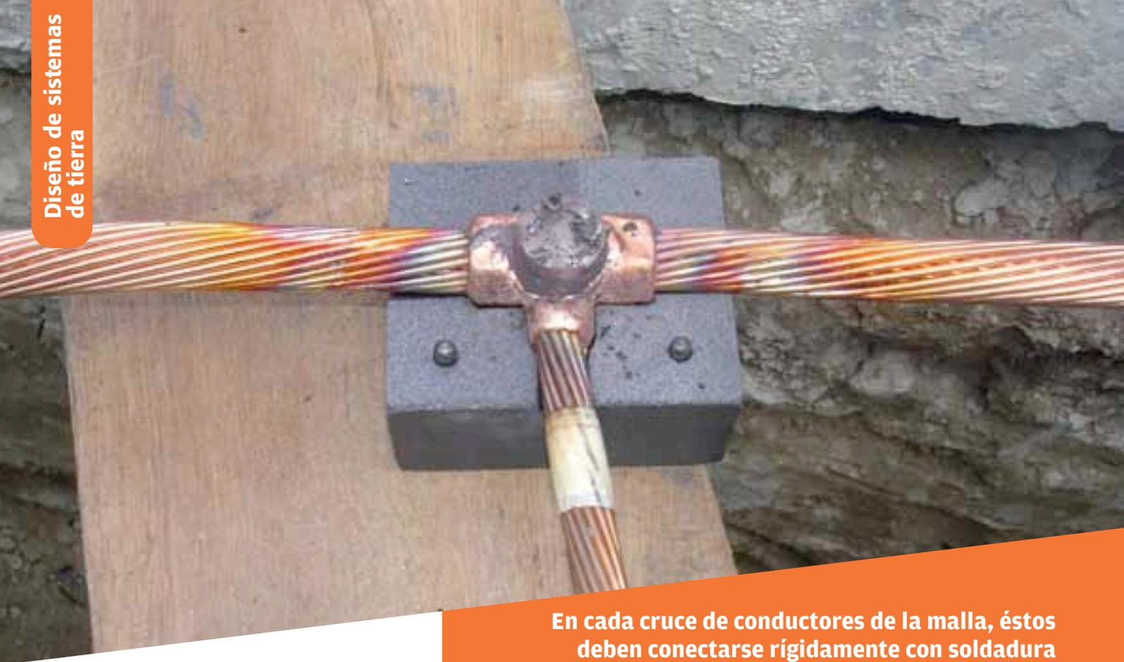
**En cada cruce de conductores de la malla, éstos deben conectarse rígidamente con soldadura exotérmica entre sí**
