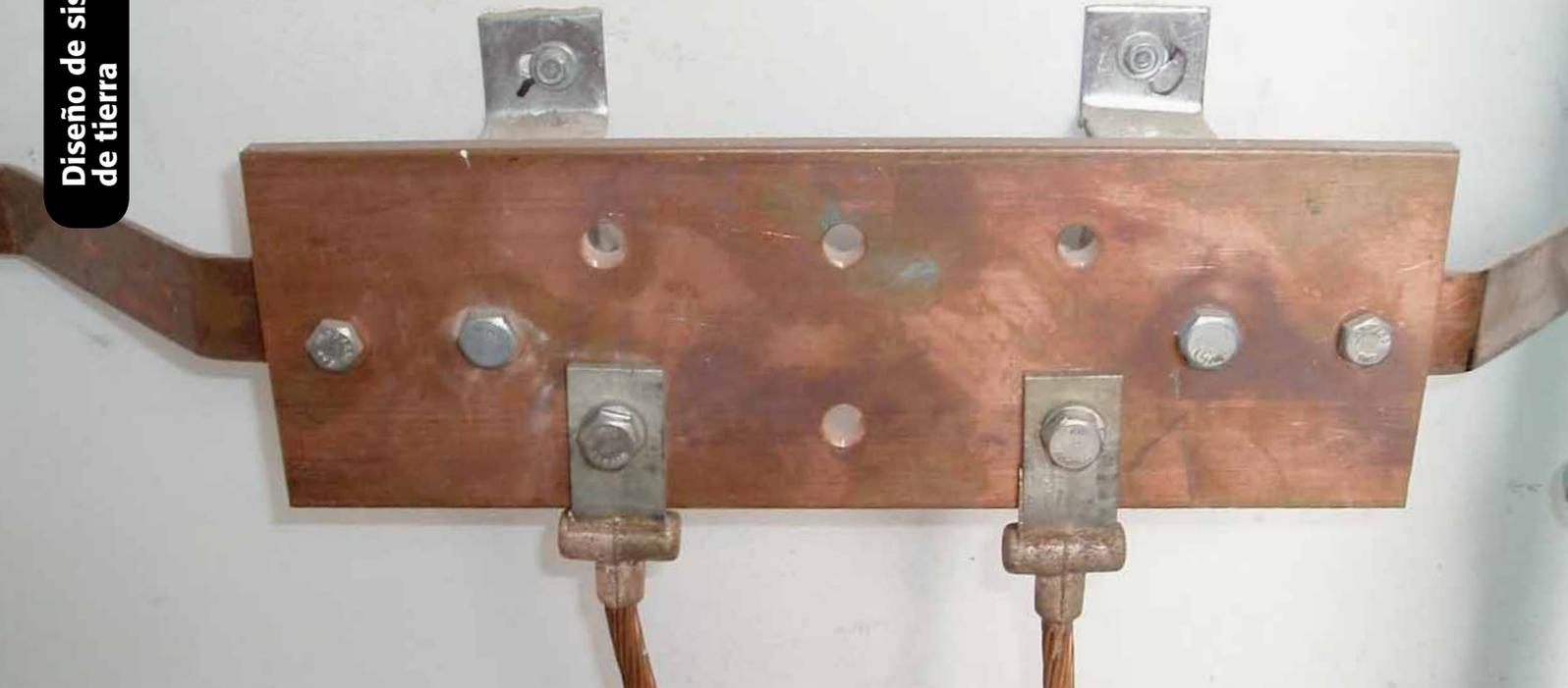
En el caso de las instalaciones eléctricas residenciales, la Comisión Federal de Electricidad solicita como requisito para colocar el medidor, instalar un electrodo de puesta a tierra que pone a tierra la terminal del neutro de la base de medición.
