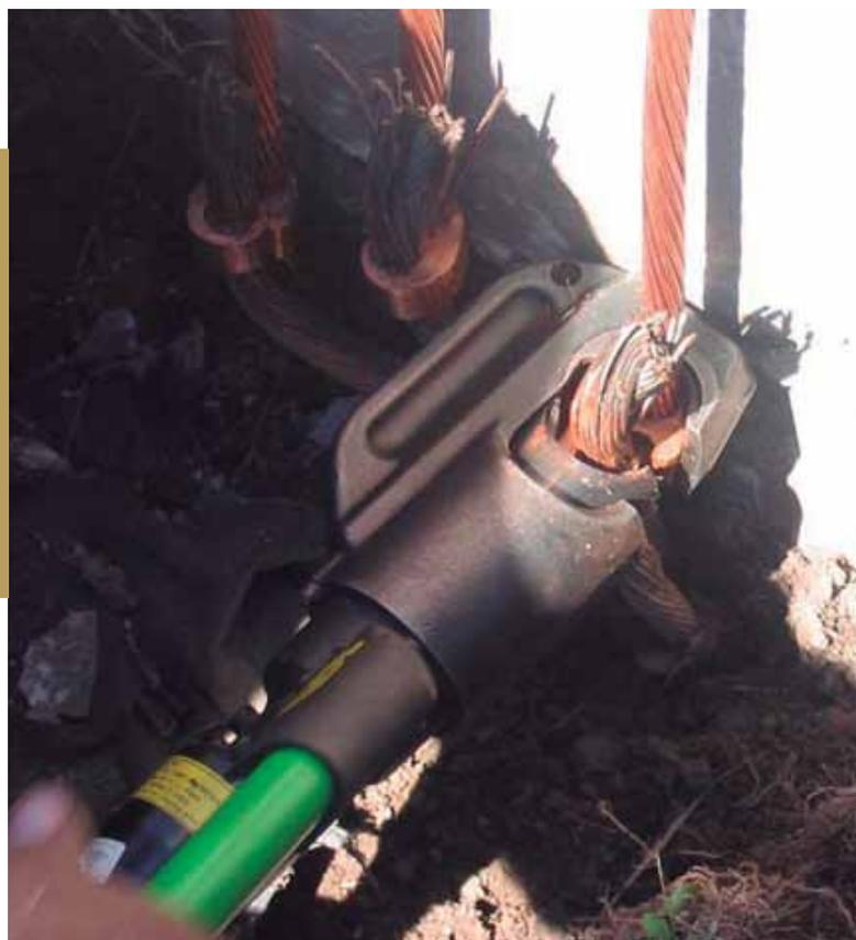
El conductor de 33,6 mm<sup>2</sup> (2 AWG) puede utilizarse para disminuir el calentamiento de los conductores neutros con corrientes eléctricas con un alto contenido de armónicas de tercer orden en instalaciones existentes.
