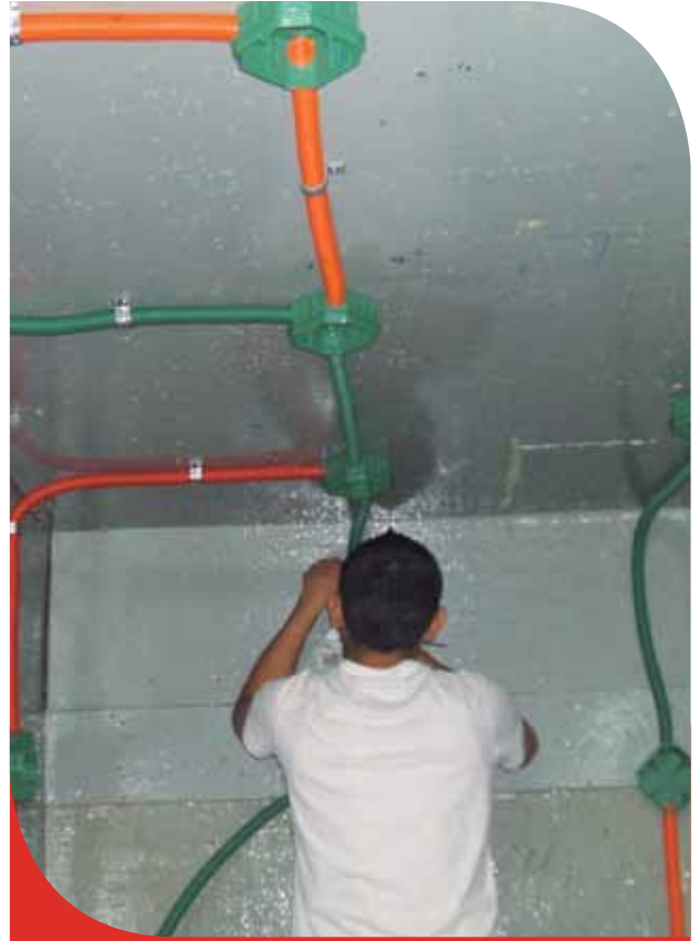
Caseta de práctica del CECATI 04
