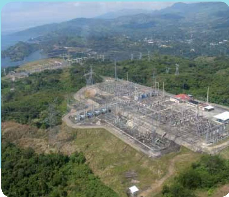
Antes de diseñar una subestación, es necesario solicitar a la compañía proveedora de energía eléctrica datos como el nivel de voltaje disponible, la variación del nivel de voltaje, el punto de entrega del suministro y la ruta de la línea, la corriente de corto circuito trifásico y monofásico en el punto de suministro y las tarifas.
