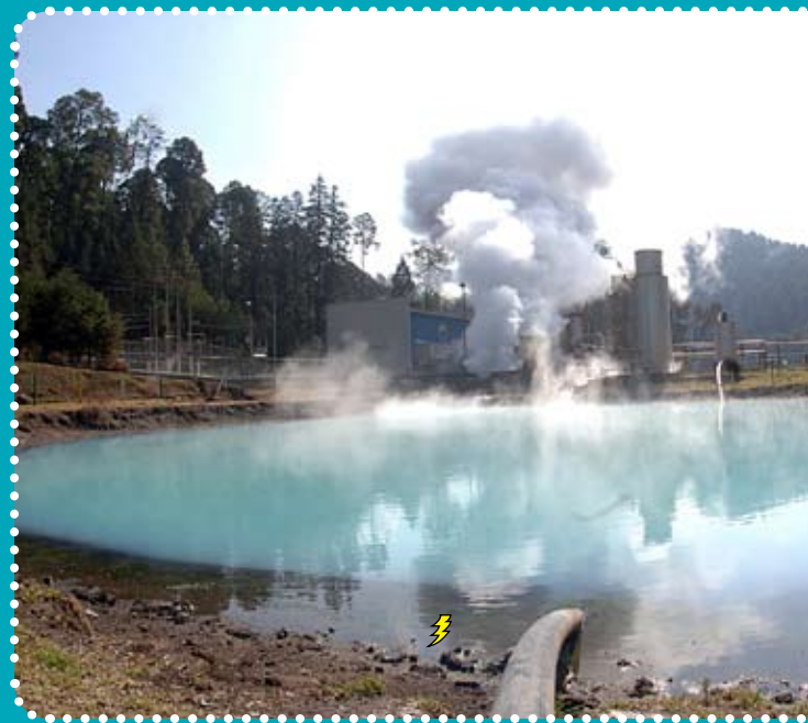
•Central geotermoeléctrica en Michoacán, México (CFE)
