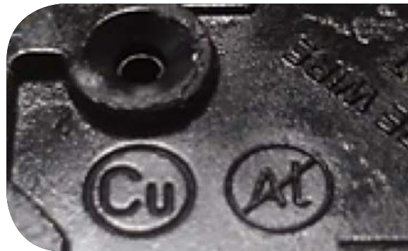
Imagen 1. Grabado del tipo de material del conductor a utilizar en las terminales.
